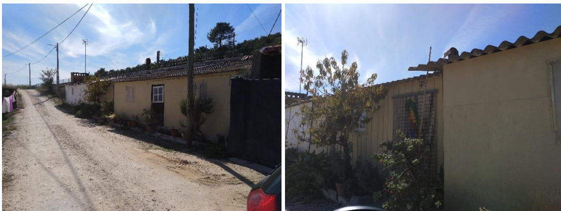
Figura 27. Núcleo precário junto à passagem de nível do apeadeiro de Santana, freguesia de Vila Chã de Ourique
